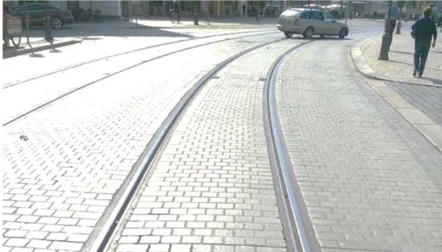
Рис. 1. Інтегрована у дорожнє покриття трамвайна колія
